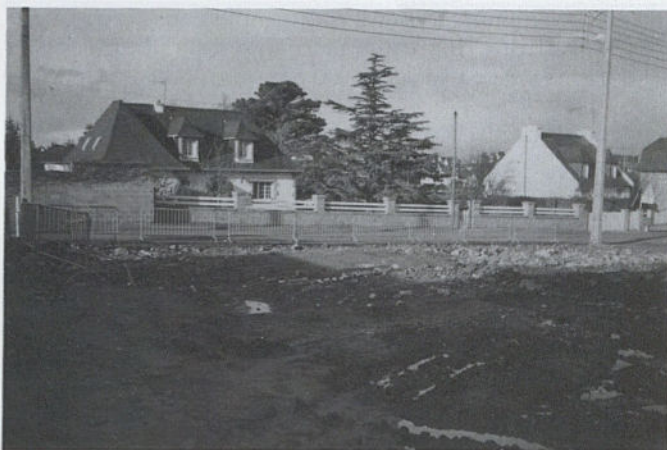
Le terrain de l'ancienne gendarmerie pour la construction du centre médico-social.
